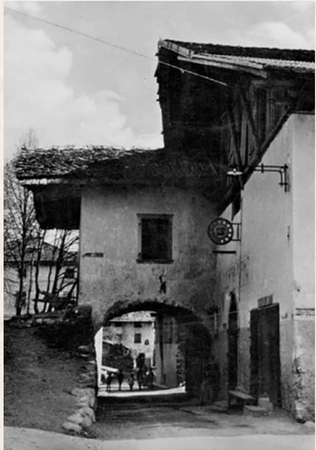
Foto storica di Preore del Volt del Pace (all'altezza dell'attuale Bar Alpino), abbattuto negli anni Cinquanta per consentire il passaggio delle corriere
