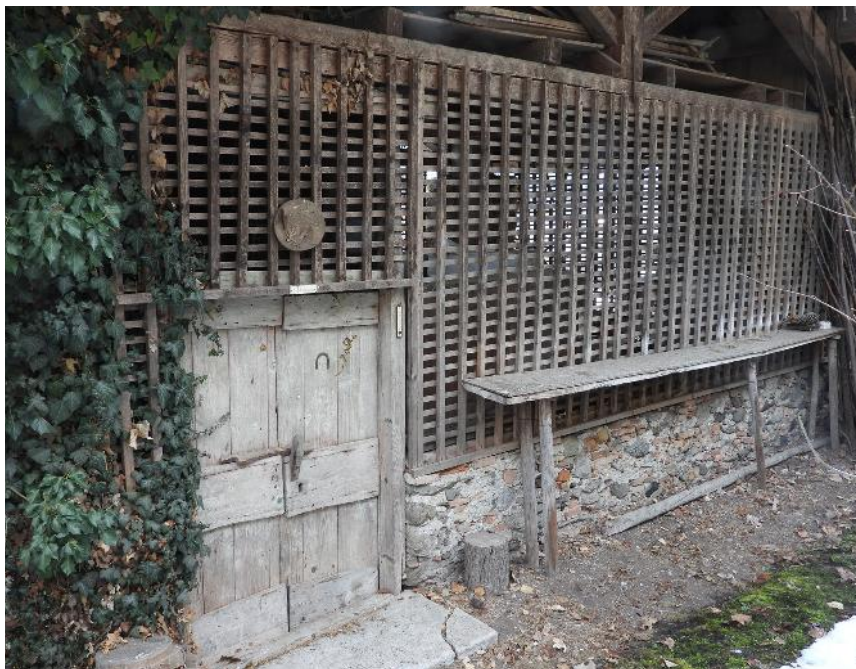
Filanda Ballardini, dettaglio del sistema per areare l'interno e garantire luce soffusa
