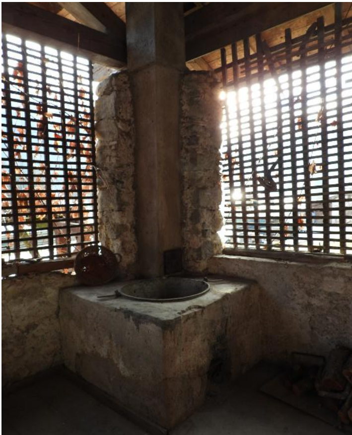
L'interno della filanda Ballardini, con l'alloggiamento per la bacinella di rame per la cottura dei bozzoli
