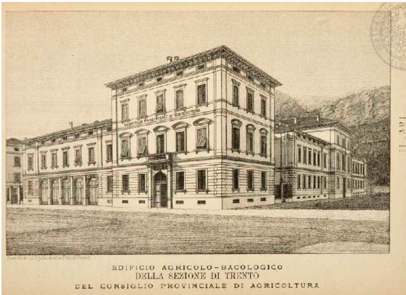
L'Istituto Bacologico di Trento nell'Ottocento. Attualmente l'edificio ospita la facoltà di Economia dell'Università di Trento
