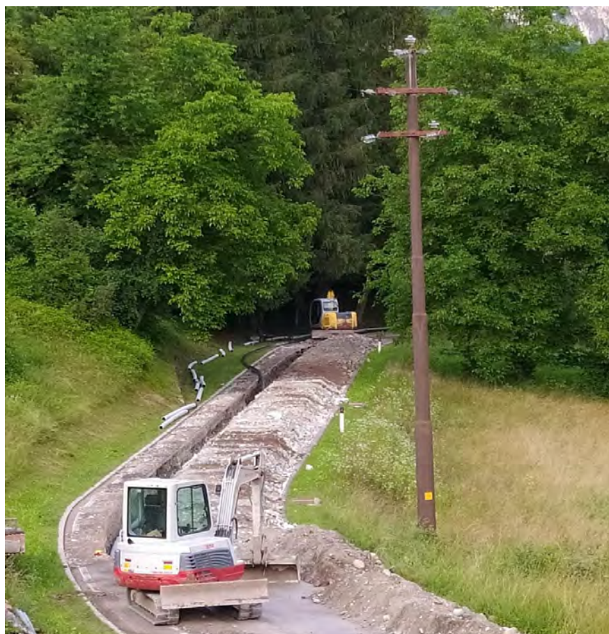
I lavori di metanizzazione delle frazioni
