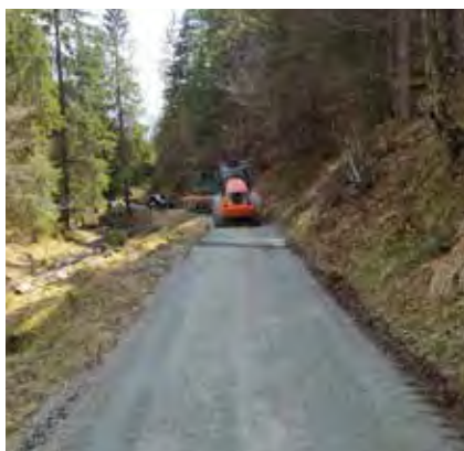
RIFACIMENTO DI UN TRATTO DELLA STRADA FORESTALE IN VAL MANEZ (Acqua dal Cheo - Legranot)
