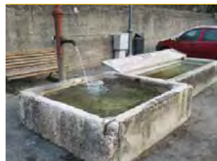
PARTICOLARE DELLA FONTANA ANTE INTERVENTO
