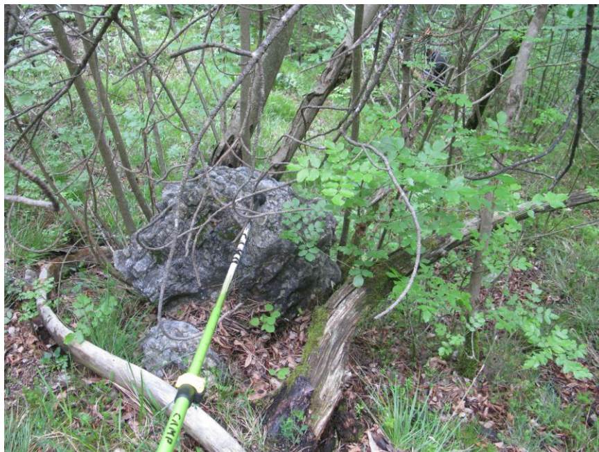
Foto n°9: blocco franato ( V \approx 0.12 \text{ m}^3 ) - (punto n°6).
