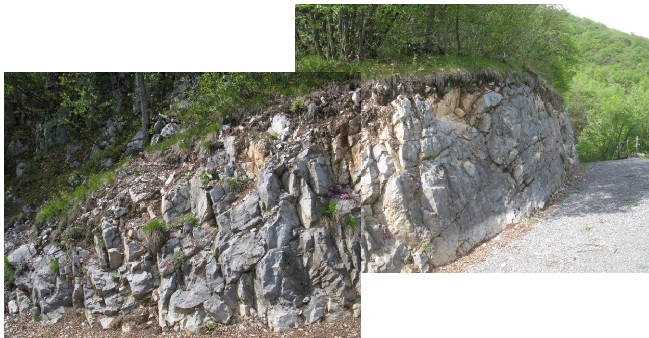
Foto n°2: roccia molto fratturata (Calcere di Zu) affiorante lungo la strada forestale a q. 967.
